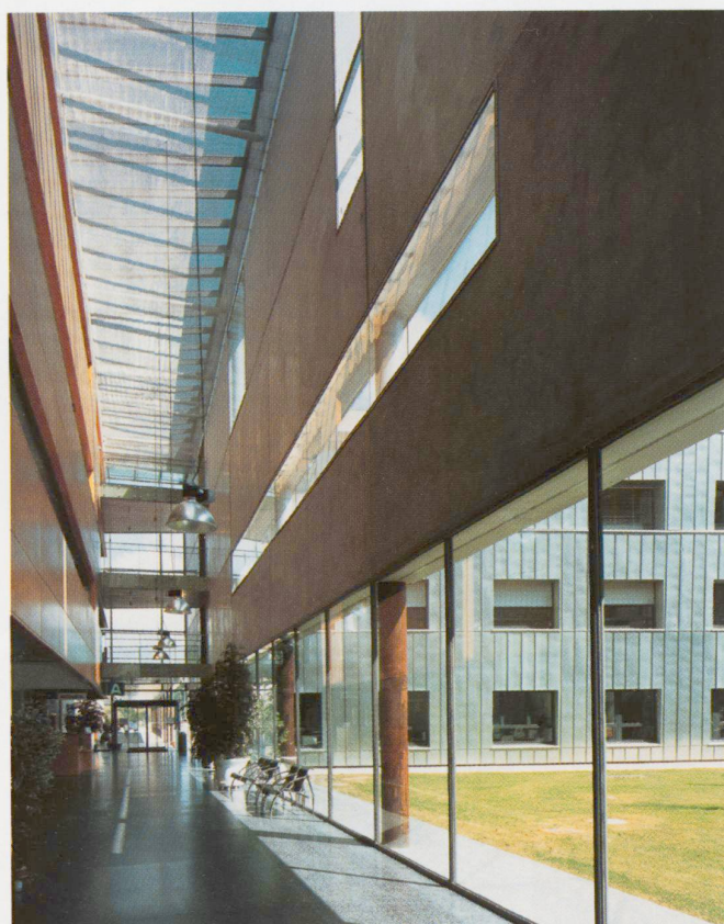
Foto 2: Planibel ENERGY: un vetro isolante selettivo con un grado di comfort particolarmente elevato: bassa emissività U=1.1 W/m^2K e controllo solare
