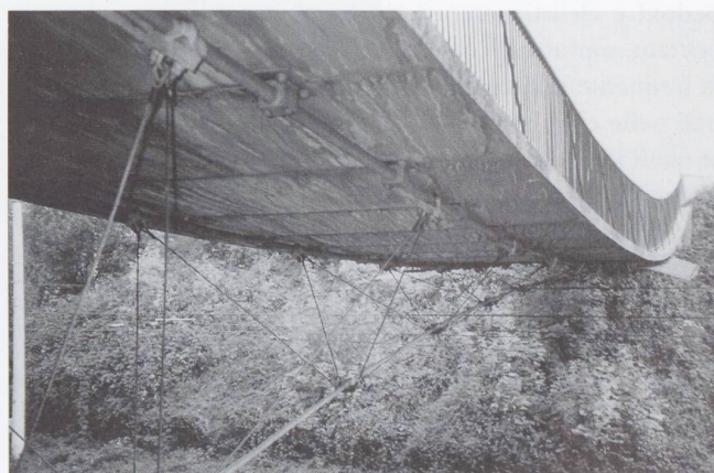
Viaduc de Maupré, Charolles F, progetto ed esecuzione impresa Campenon-Bernard, 1988: struttura a cassone con anime in lamiera ondulata e tubo inferiore in acciaio con riempimento in calcestruzzo, luci variabili tra 41 e 53 metri
