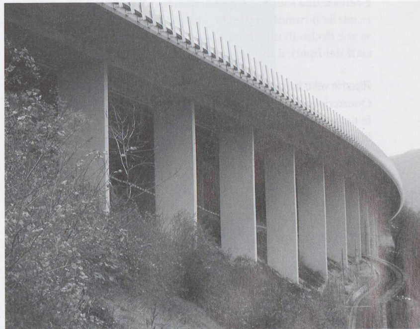
Fig. 8 – Vista del manufatto dopo l'intervento
