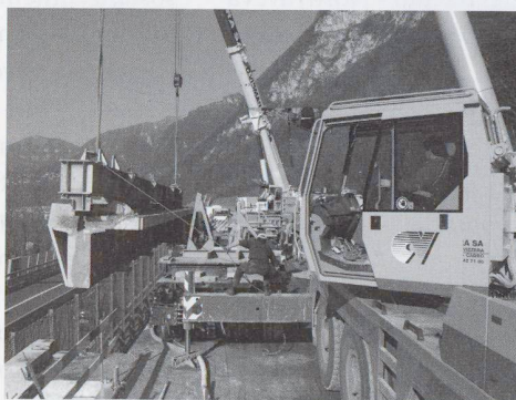
Fig. 4 - Rimozione delle travi di bordo
