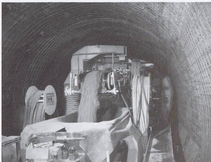
Fase di scavo della TBM
