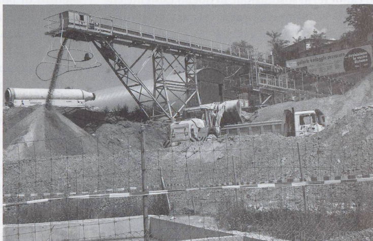
Gestione del materiale di scavo (evacuazione tramite nastro trasportatore)
