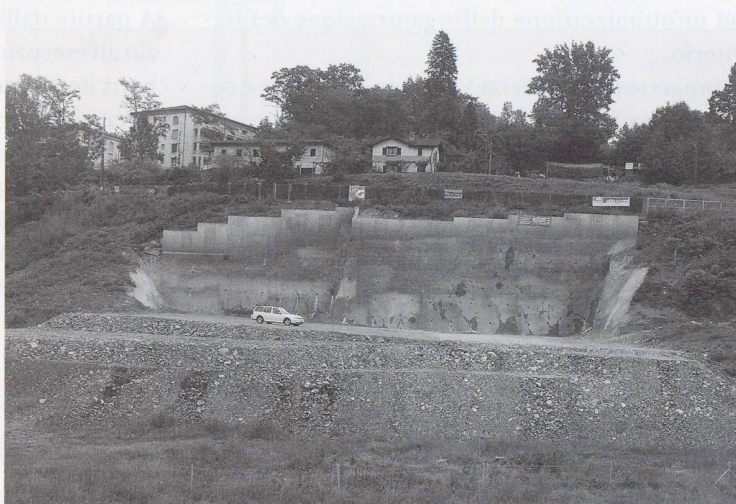
Scavo di approccio al portale Vedeggio ultimato
