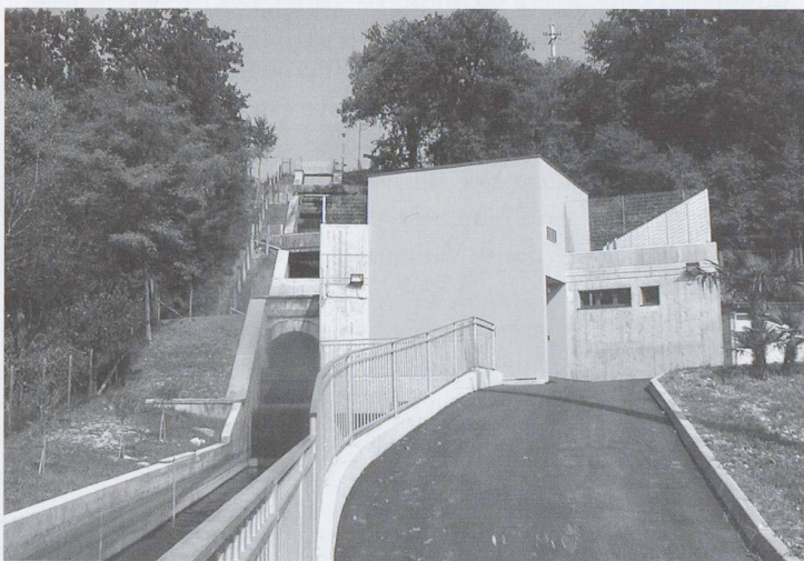
Fig. 4 e 5 – La forza dell'acqua Centrale dell'impianto di Castel Montecchio (BG), 3'036 kW Centrale dell'impianto di Esenta (BS), 1'150 kW
