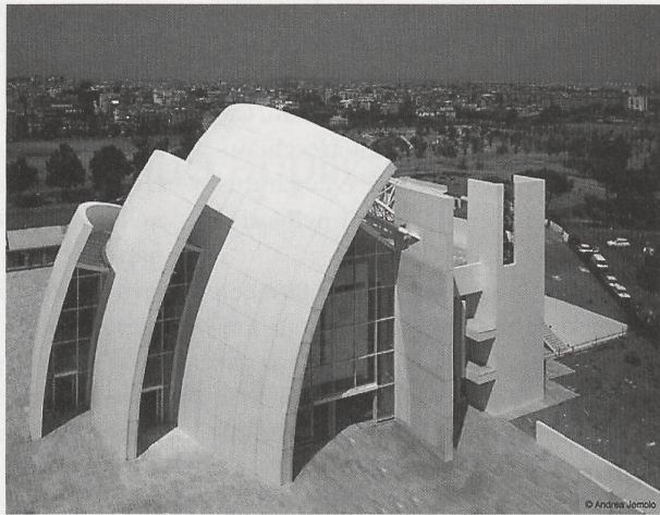
Fig. 3 – Chiesa «Dio Padre Misericordioso» a Roma. Il colore duraturo chiaro è ottenuto con particelle di ossido di titanio e di marmo nel calcestruzzo.
