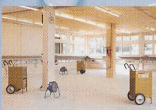
Prosciugamento di stabili
