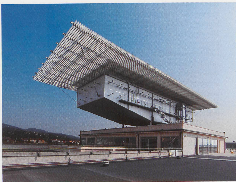
Fig. 9 – Copertura a sbalzo Pinacoteca «Giovanna e Marella Agnelli» Lingotto di Torino (2002), Renzo Piano Building Workshop
