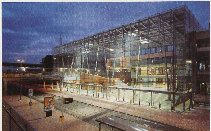
Fig. 7 – Facciata in vetro a cavi paralleli all'Università di Bremen
