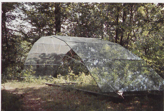
Fig. 9 – Glass Arch nr.1 con una campata di 10m
