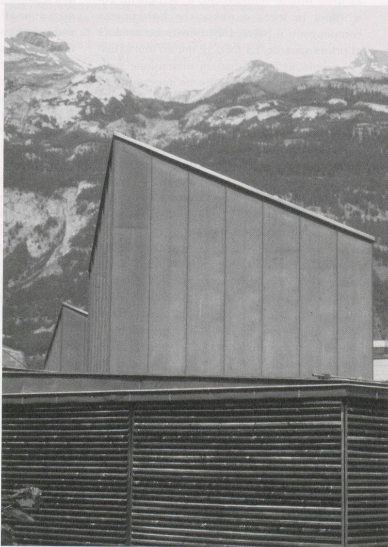
Peter Zumthor, dettaglio copertura delle strutture di protezione dei ritrovamenti romani a Coira (foto P. Tormenta Pinto)
