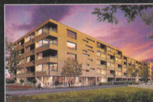
Casa anziani Arlesheim - CH Architekten
