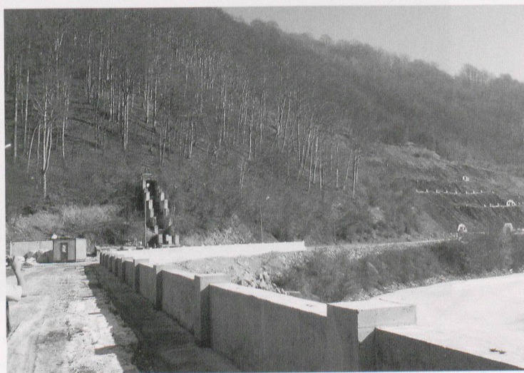
Fig. 1 – Bacino artificiale di Sacele: vista della diga dalla parete di frana Fig. 2 – Bacino artificiale di Sacele: vista della parete di frana dalla diga
