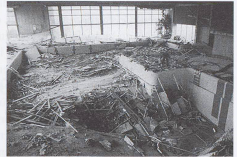
Fig. 2 – Componente della «colla» cementizia vista al microscopio a scansione (cristalli di ettringita) Fig. 3 – La piscina coperta di Uster dopo il crollo del soffitto ribassato in calcestruzzo armato (1985)
