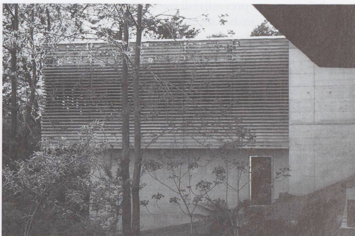
Involucro in lamelle di legno di castagno ad inclinazione variabile in funzione dell'altezza. Parcheggio pubblico Orselina
