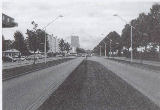
Amsterdam, strada di collegamento
