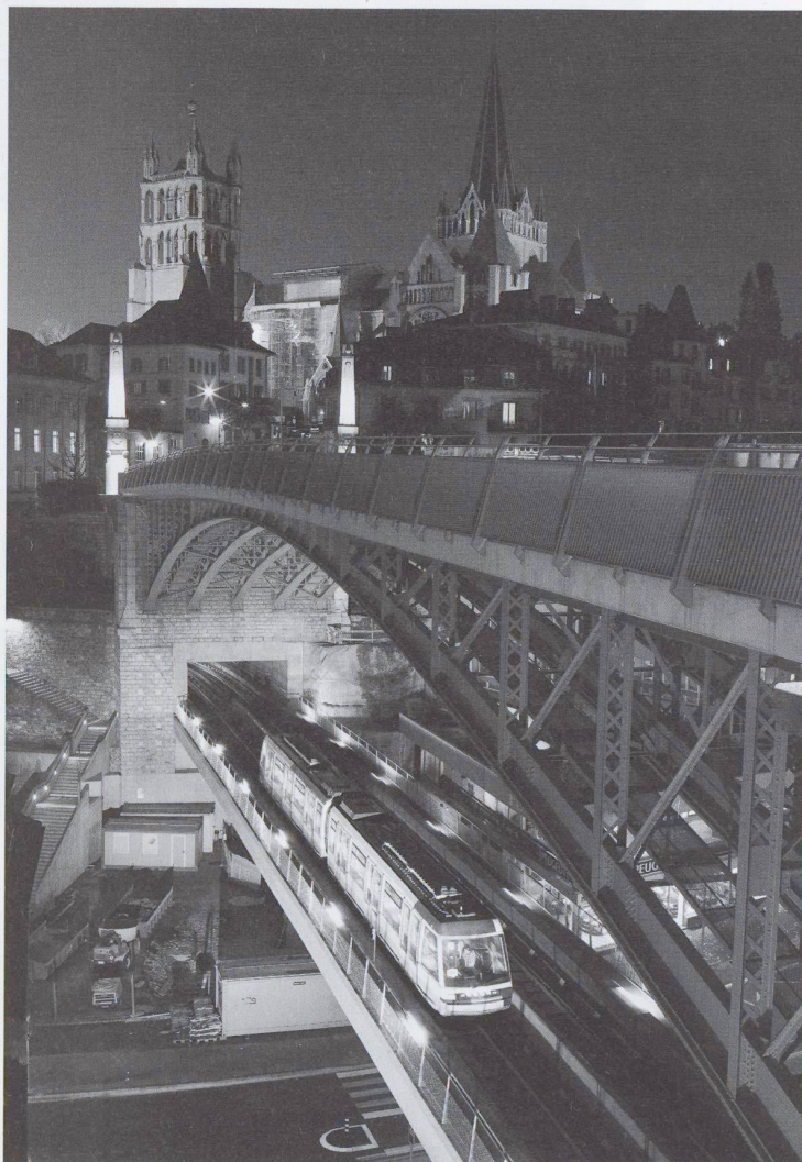
Fig. 1 – Il ponte Saint-Martin sotto il ponte Bessières. Sullo sfondo la cattedrale di Losanna (Foto M. Schobinger/MLO SA)
