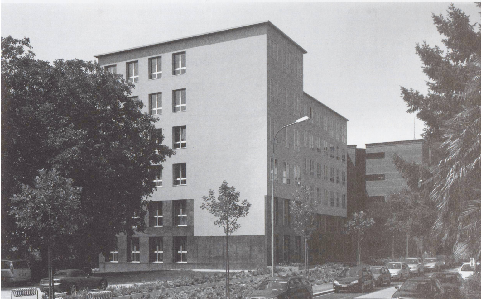
Prima fase di realizzazione
