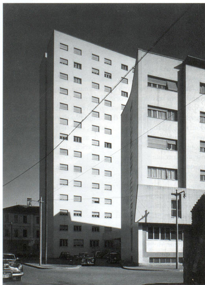
11.,12. L. Moretti, casa albergo di via Corridoni, 1947-50. Veduta del complesso da via Respighi (Archivio Centrale dello Stato di Roma, Fondo Luigi Moretti).
