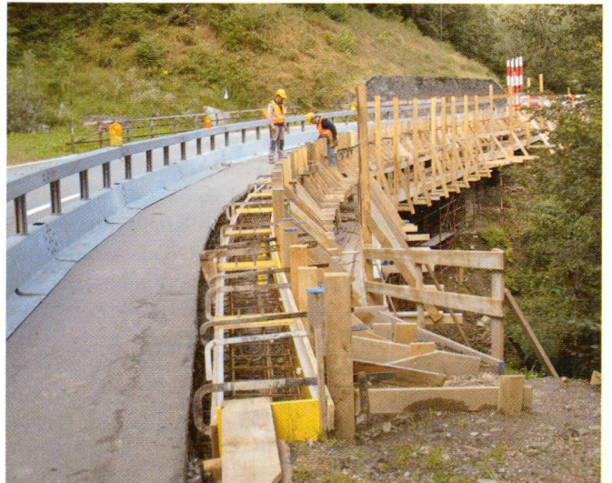
Intervento di manutenzione. Rifacimento cordolo
