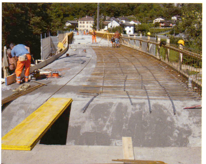
Intervento conservazione. Restauro conservativo
