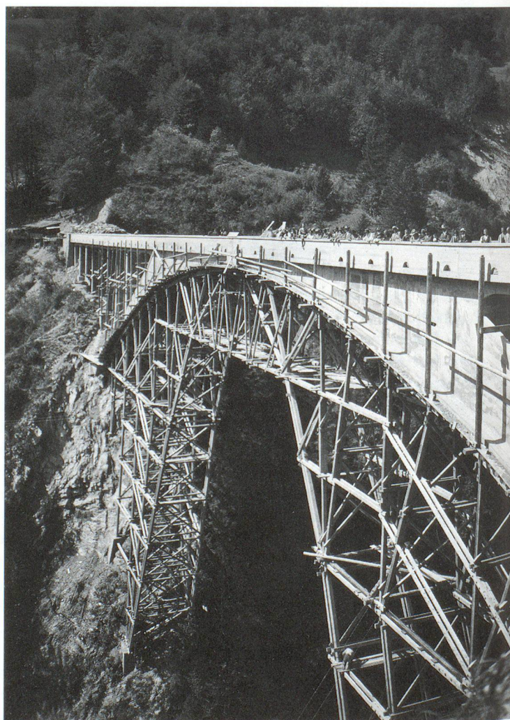
Viadotto di Salginatobel tra Schiers et Schuders, di Robert Maillart, 1929-1930
