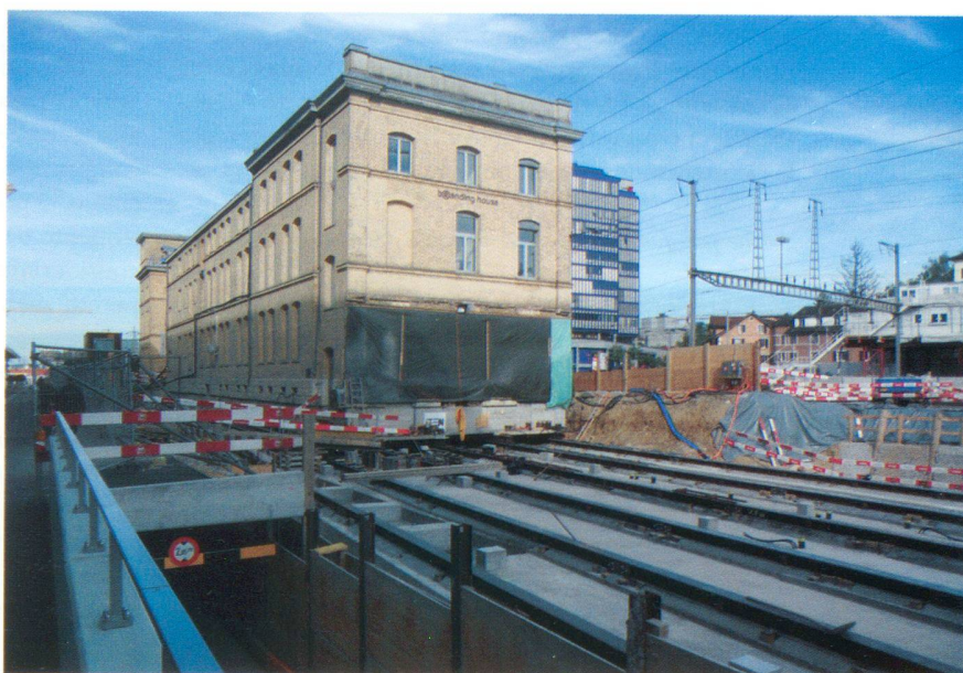
Una fase dello spostamento dell'ex sede amministrativa della Werkzeug- und Maschinenfabrik Oerlikon (MFO)
