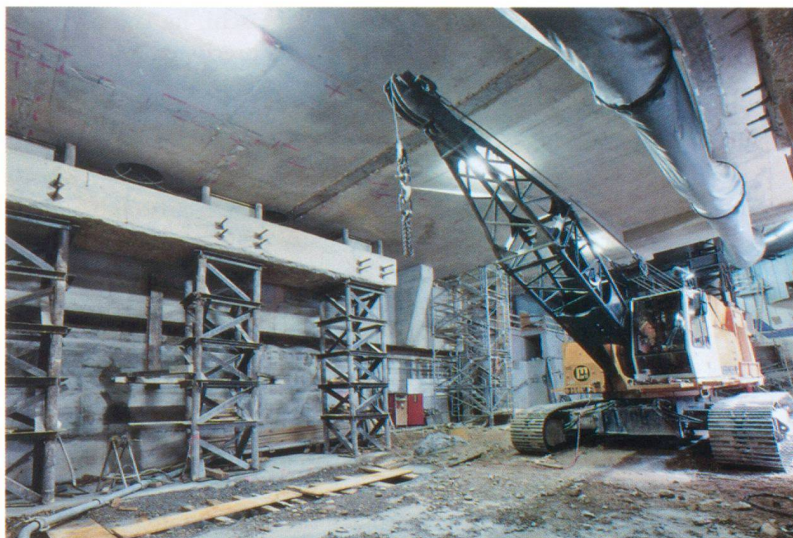
Diaframmi a pali realizzati negli spazi angusti della Querhalle IG ZALO, Poyly Infra AG
