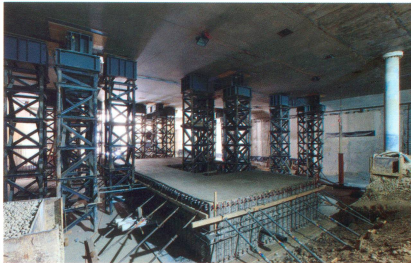
Torre di micropali trivellati IG ZALO, Poyly Infra AG
