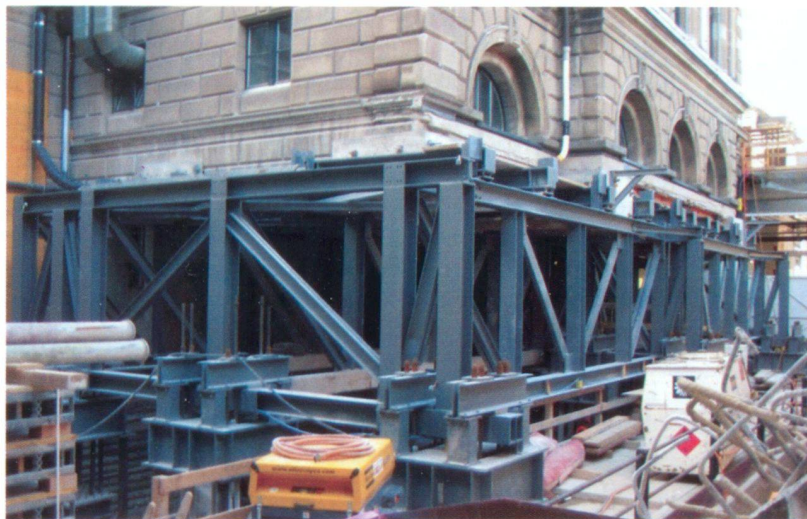
Sottomurazione reticolata IG ZALO, Poyly Infra AG
