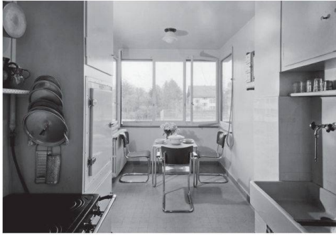
5. Atelier des Architectes, fabbricato in Chemin Krieg 3 (1933-1934), veduta della cucina e della zona pranzo (Archivi dell'Università di Ginevra, archivi d'architettura, fondi Saugey, foto Boissonnas)
