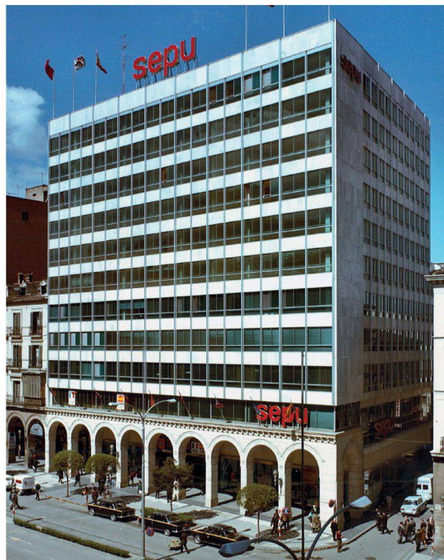
L'edificio della SEPU, Zaragoza 1963-1967
