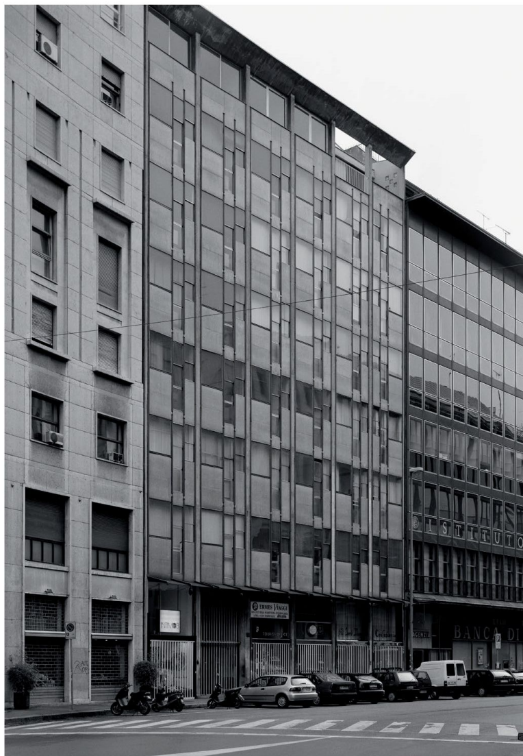
5. Vico Magistretti, edificio per uffici in corso Europa a Milano, 1955-57. Foto Gabriele Basilico
