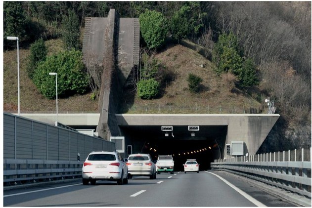
3 - 4. Rino Tami, autostrada A2, portale della galleria a Melide, 1967
