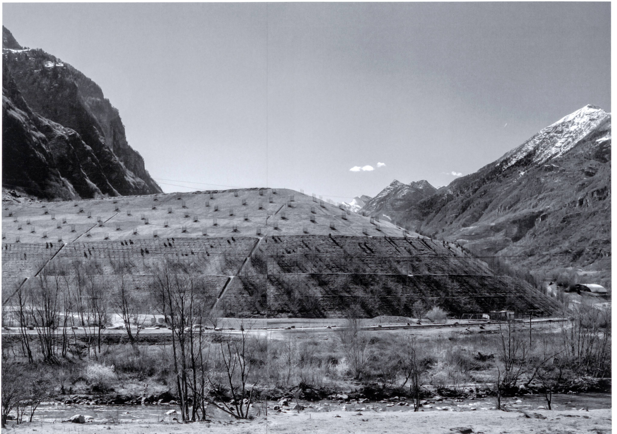
Sistemazione del deposito della Buzza, Biasca. Foto Marcelo Villada Ortiz
