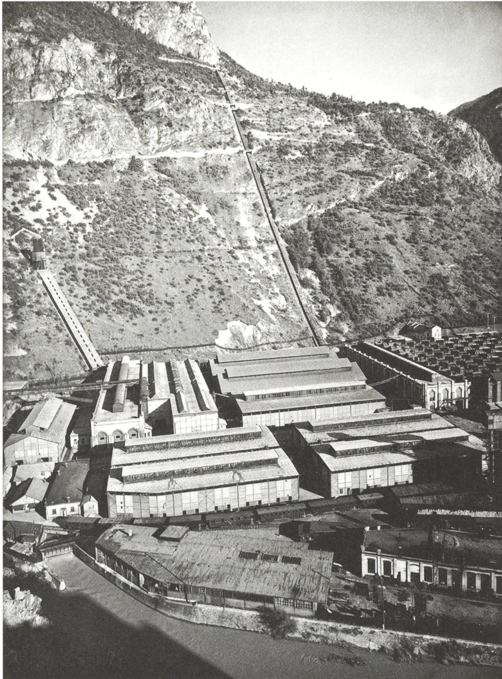
Teilansicht des Fabrikgeländes der AIAG in Chippis während des Ersten Weltkriegs. Der Sprengstoffanschlag erfolgte gegen die rechte der beiden vom Berghang herunterführenden Leitungen. Das Salpetersäurewerk befand sich in den drei unmittelbar darunter liegenden, orthogonal zur Druckleitung verlaufenden Fabrikhallen. (AIAG Chippis, Médiathèque Valais – Martigny)
