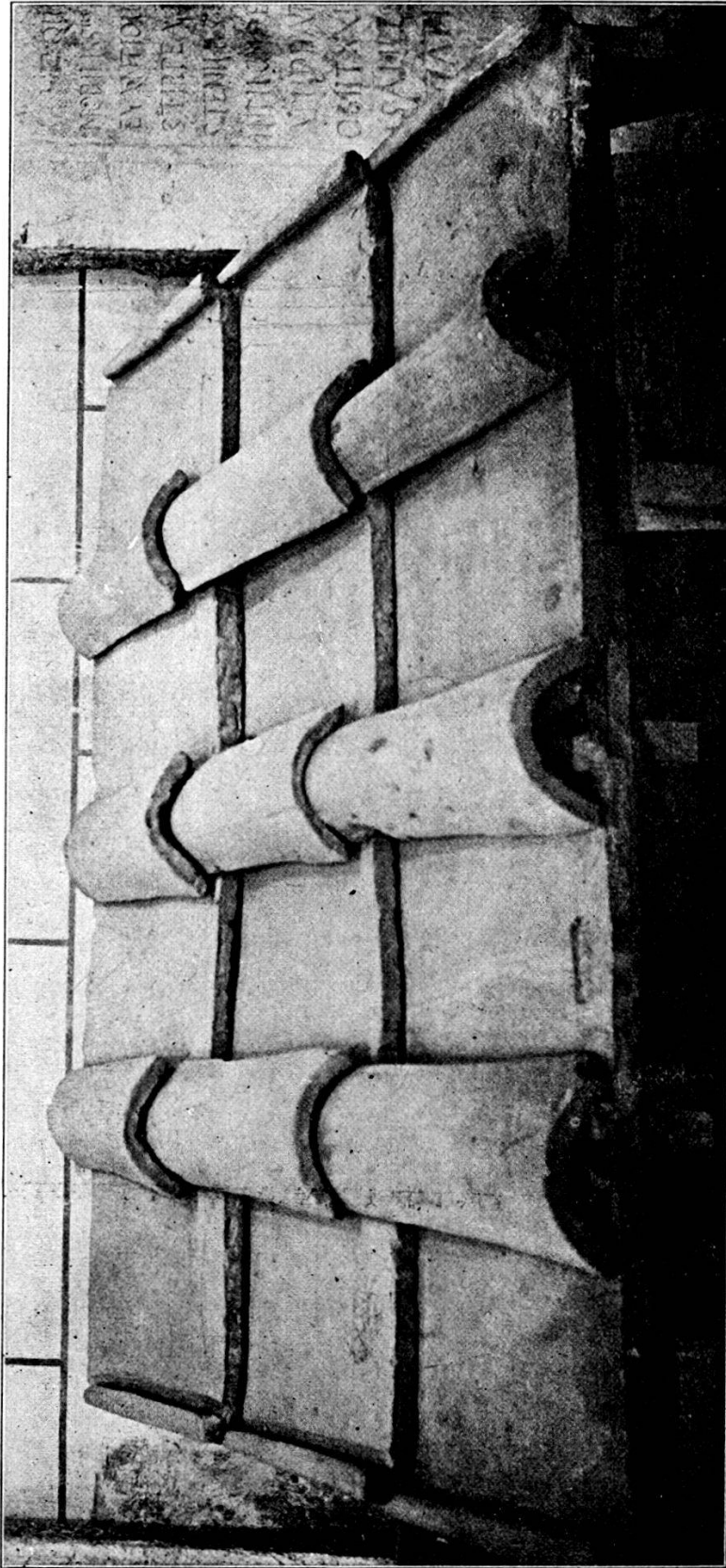
2. Ziegeldach, rekonstruiert aus Ziegeln der XI. und der XXI. Legion, die im Windischer Lager gefunden wurden (Sammlg. der Ges. Pro Vind.).
