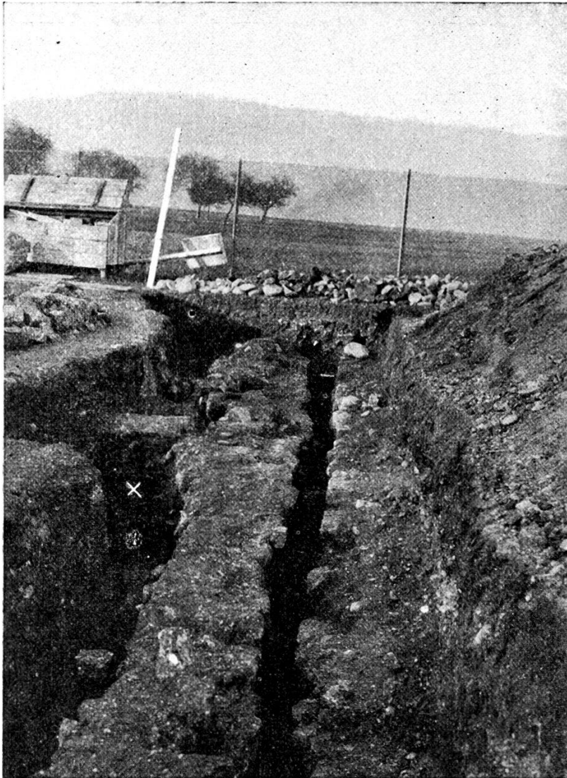
31. Gemauerter Kanal neben der Via principalis. Grabg. 1908. × Kanal von Westen. Anzeiger 1909, S. 41 ff.
