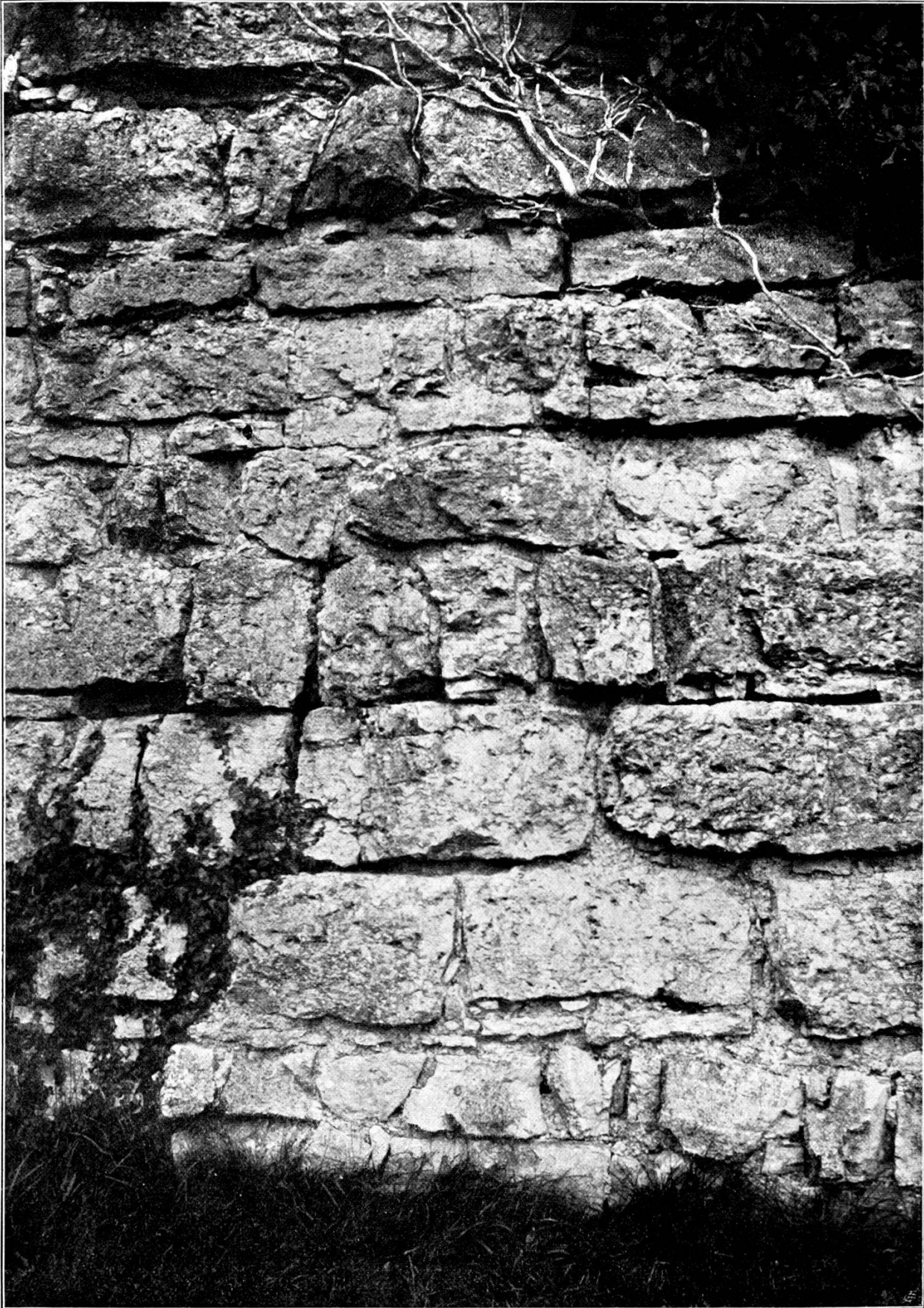
Ein Ausschnitt aus der westlichen Mauer des Turmes (Bergfrides) der Habsburg, erbaut ums J. 1020. Zur Vergleichung der rohen Art des Mauergefüges gegenüber der am Schwarzen Turme in Brugg, der älter ist.
