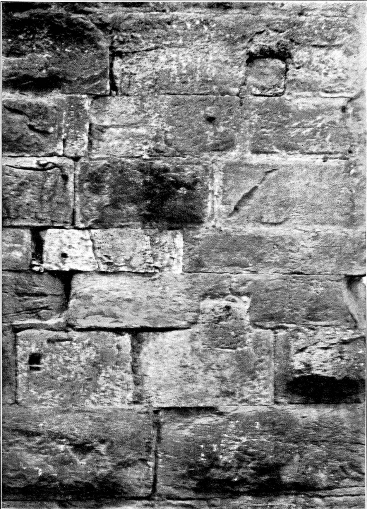
Ein Stück aus der Quadermauer am untern, ältern Teile des Schwarzen Turmes in Brugg. Die Technik und das Aussehen verraten römischen oder romanischen Einfluß. An einigen Stellen wurde die Mauer durch die spätmittelalterliche Toranlage der Stadt Brugg beschädigt (durchbrochen).
