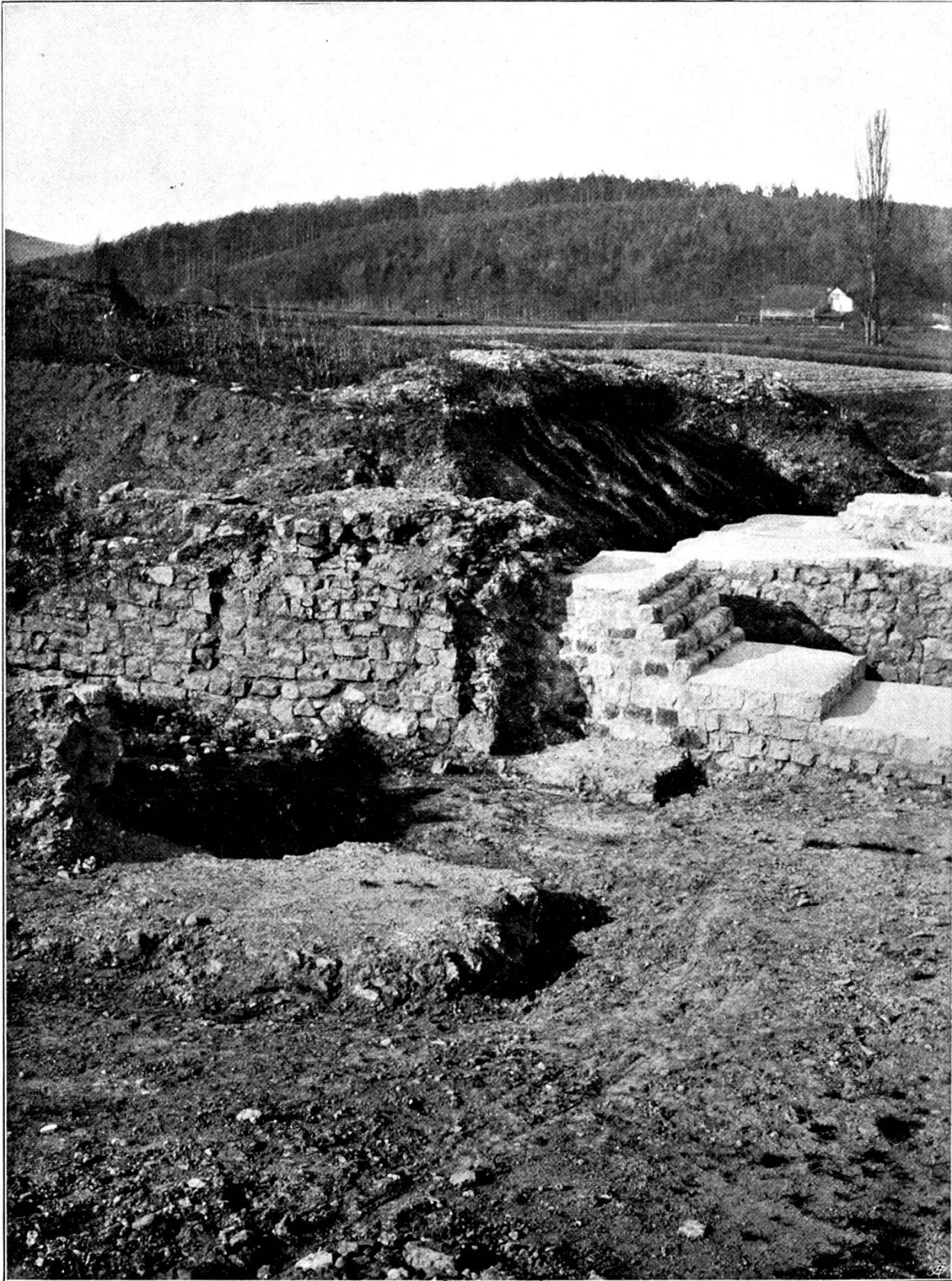
Amphitheater, Nordeingang (rechts, westlich); aufgenommen bei Beginn der Conservierung 1901.
