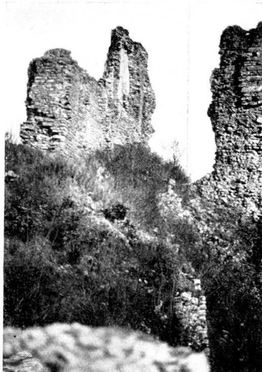
Palas und Bergfried vor der Sicherung.
