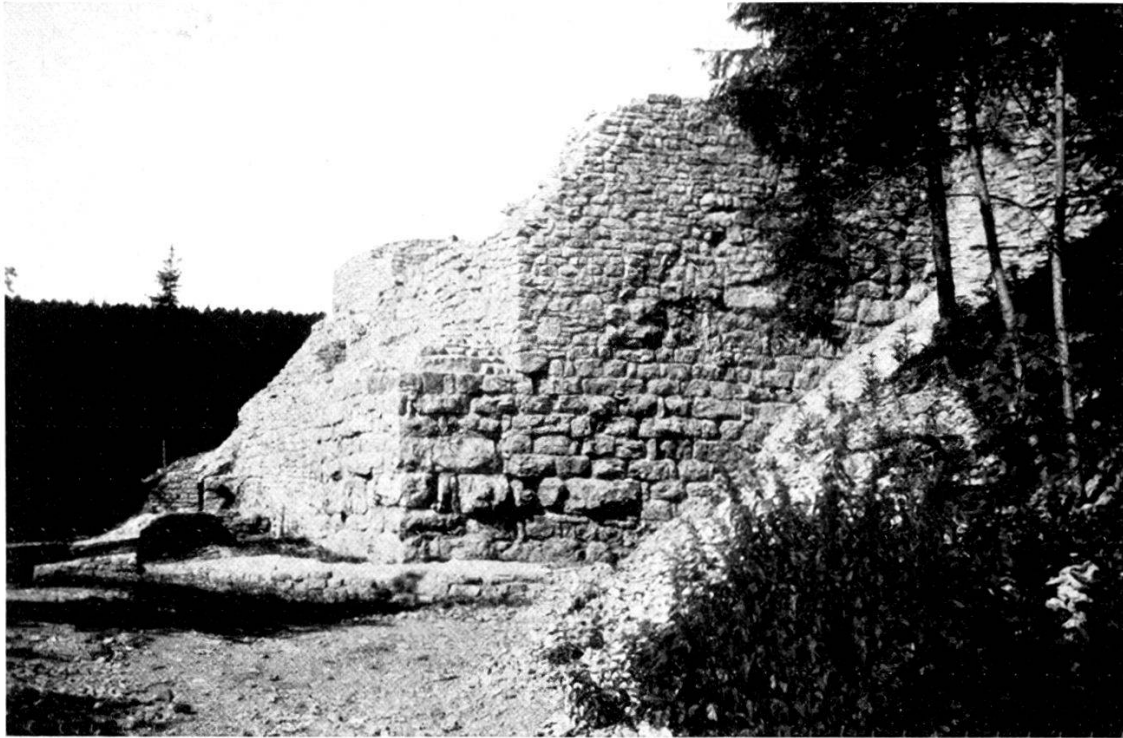
Bild 16. Ofsteele der Burganlage.
