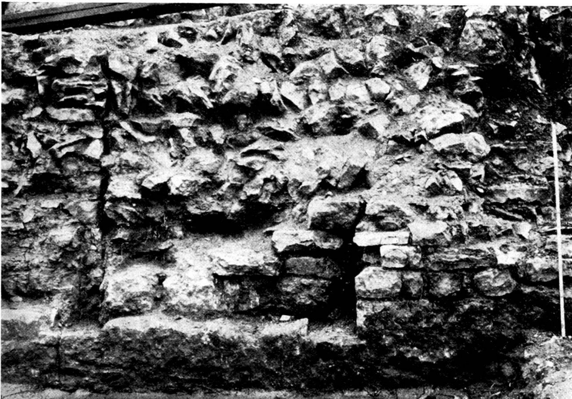
Bild 10. Der vermauerte Türeingang von Raum X nach Raum VIII.
