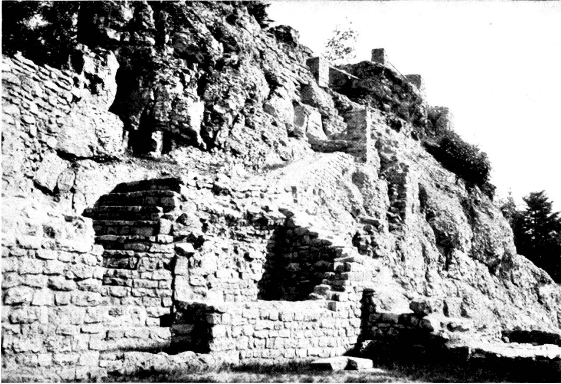
Bild 9. Treppe und Aufstiegsrampe nach Terrasse 1.
