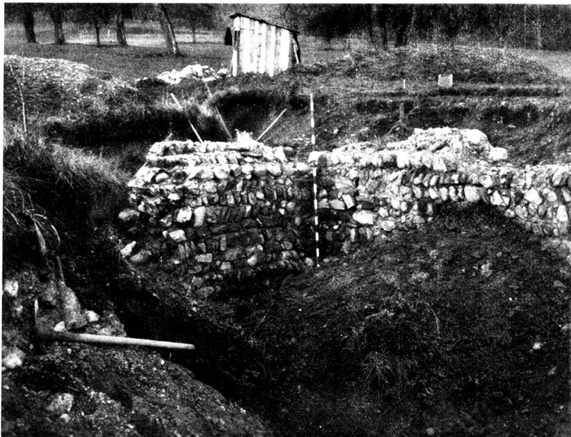
Abb. 5. Mauerwerk des Palas.
