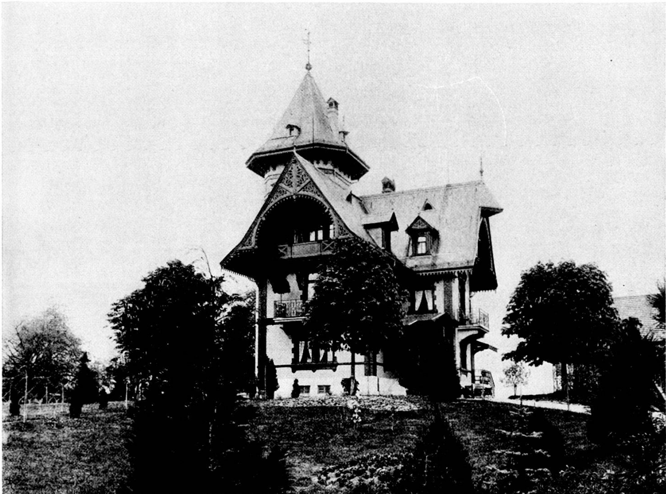
Abb. 16. Strohindustriellen-Villa, 1894 von Fabrikant Carl Vock erbaut
