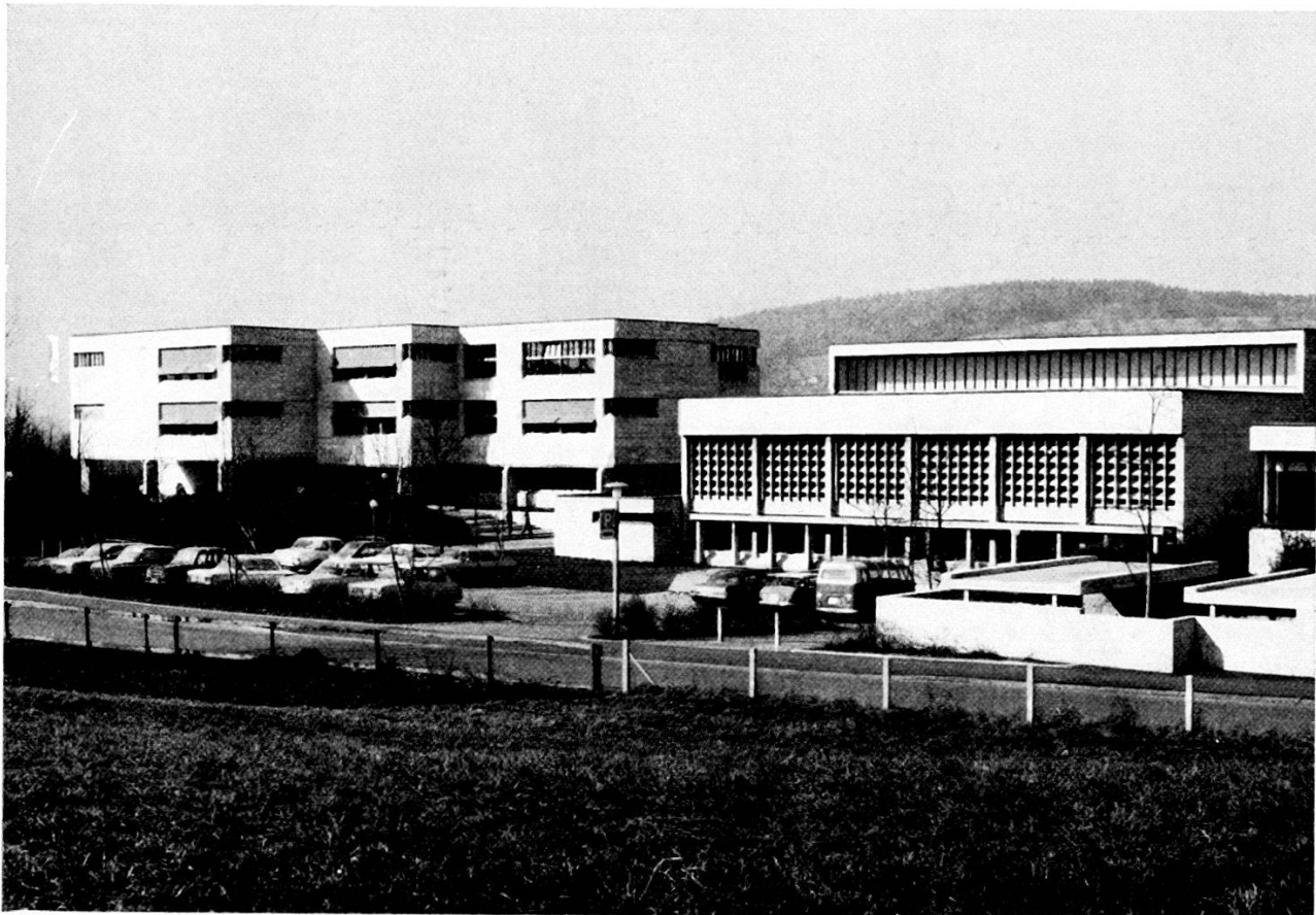
Abb. 46. Die Bünzmattschulhäuser, 1966 und 1971 erbaut
