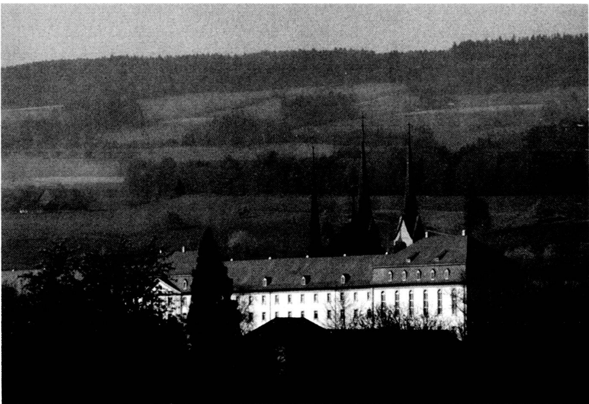
Aargauisches Kranken- und Pflegeheim 1989 nach der Dach- und Fassadenrestauration
