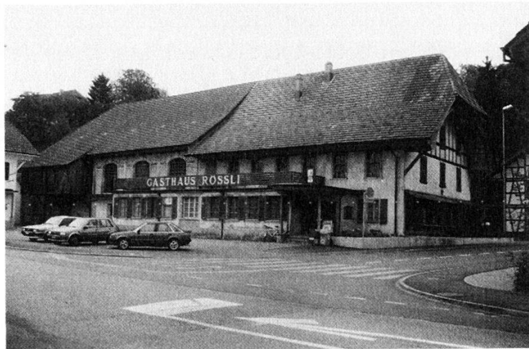
Abb. 7. Heutiger Zustand des Gasthauses Rössli in Rothrist. Blick von der Bernstrasse Richtung Südosten.
