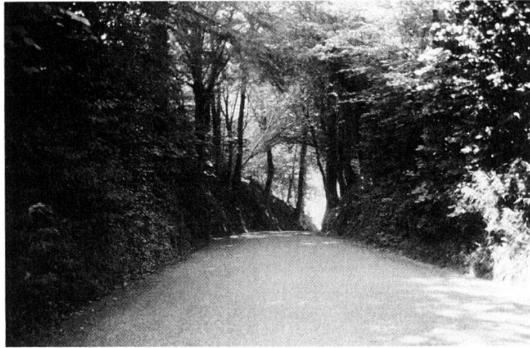
Abb. 5. Hohlweg bei Bösewil in der Gemeinde Brittnau. Bestockte Böschungen bilden ein kleines Wäldchen um den Wegabschnitt und setzen so einen markanten Akzent in der offenen Kulturlandschaft.
