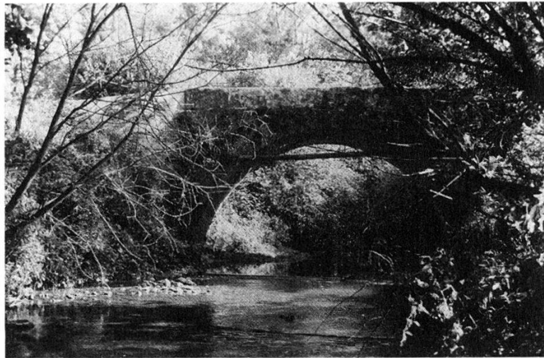
Abb. 6. Übergang vom Kanton Bern in den Kanton Aargau. Die Steinbogenbrücke verbindet Roggwil mit dem Weiler Walliswil in Murgenthal. Trotz des eingefügten Betonelementes und des aufgehängten Kabelkanals ist der Eindruck des ursprünglichen Bauwerks erhalten geblieben.
