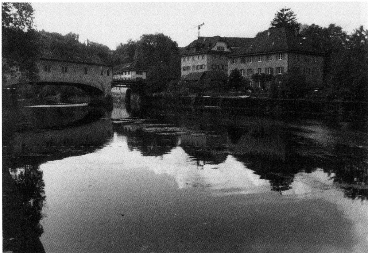
Abb. 21. In schönem Bogen zieht die Brücke auf den Zwischenpfeiler und findet ihre Fortsetzung in der Eisenkonstruktion. Das Gebäude rechts ist das Fahrhaus aus dem Jahr 1696.
