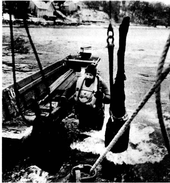
Abb. 5 Der aus dem Rheingrund gezogene Pfahl hängt am Kranseil. Der Taucher steht auf der Betonröhre (Foto BAZ).
