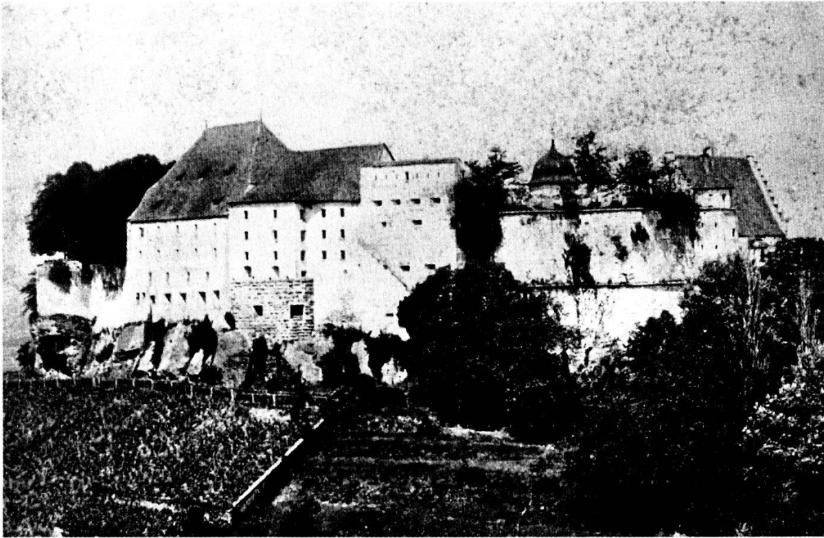
Abb. 20: Schloss Lenzburg von Südosten, vor den Umbauten 1893–1910, Photographie um 1890. Historisches Museum Aargau, Schloss Lenzburg, C 6080.
