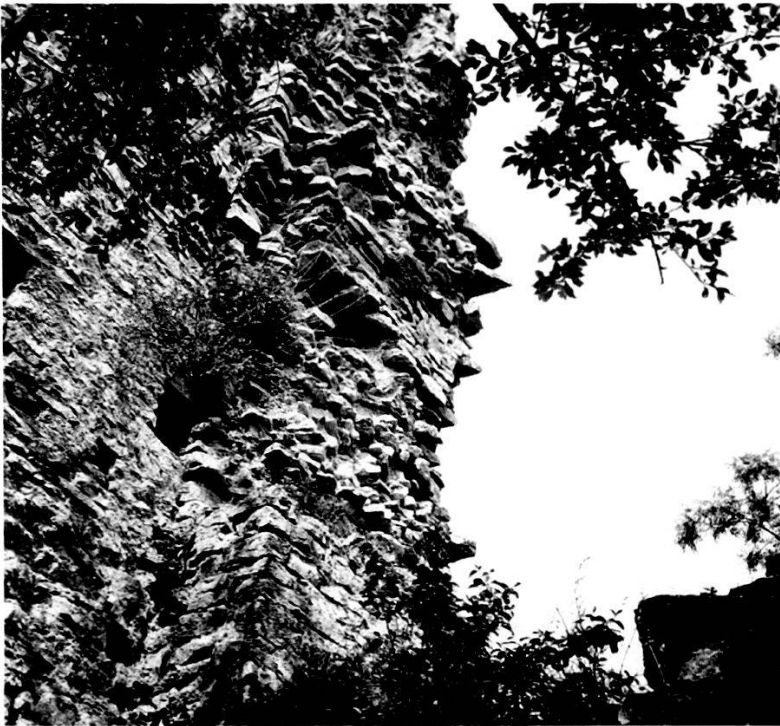
14 Hauptturm vor der Sanierung von 1969/70, von Südwesten (StAAG DEP AVH Schenkenberg).
