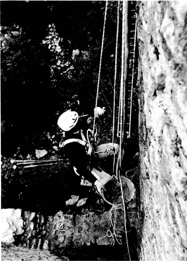
17 Ausfugen des Mauerwerks mit der Kletterausrüstung während der Sanierung 2003 (KAAG).
