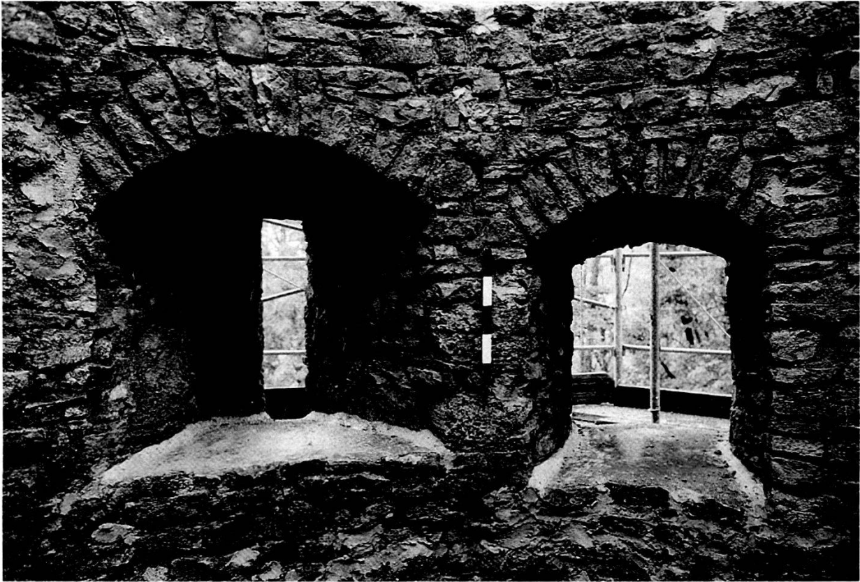
37 «Pulverturm» – Rundturm M28 2003, 1935 rekonstruiertes Schartenfenster (links) und Schlüsselscharte ohne Leibung (rechts) im 1. Obergeschoss, von Norden (KAAG).
