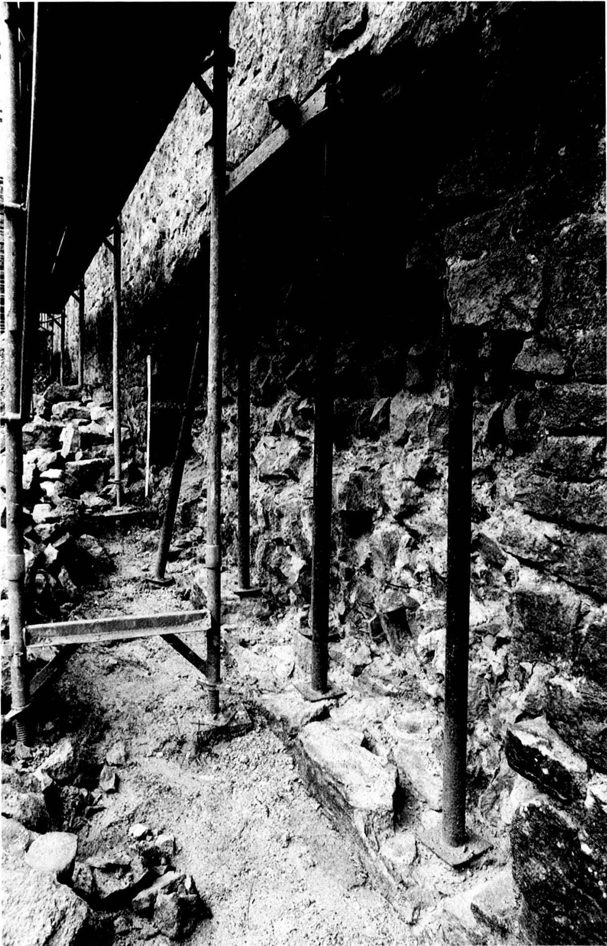
18 Mauerfuss der Schildmauer M7 während der Sanierung von 2003, von Nordwesten (KAAG).
