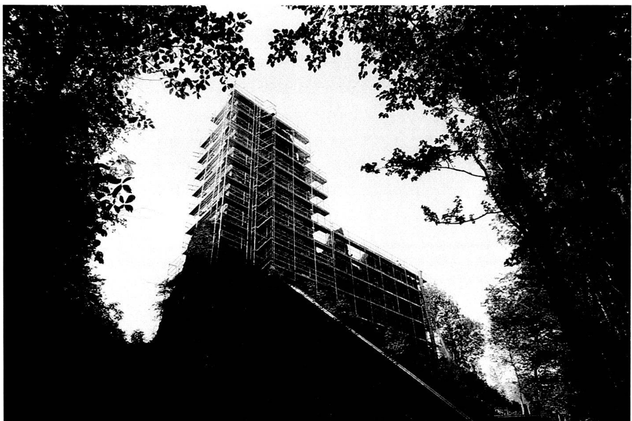
15 Hauptturm und Schildmauer während der Sanierung 2003, von Nordosten (KAAG).
