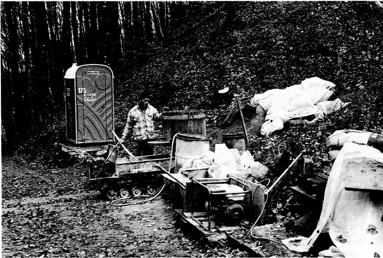
16 Mörtelmischplatz während der Sanierung 2003 (KAAG).
