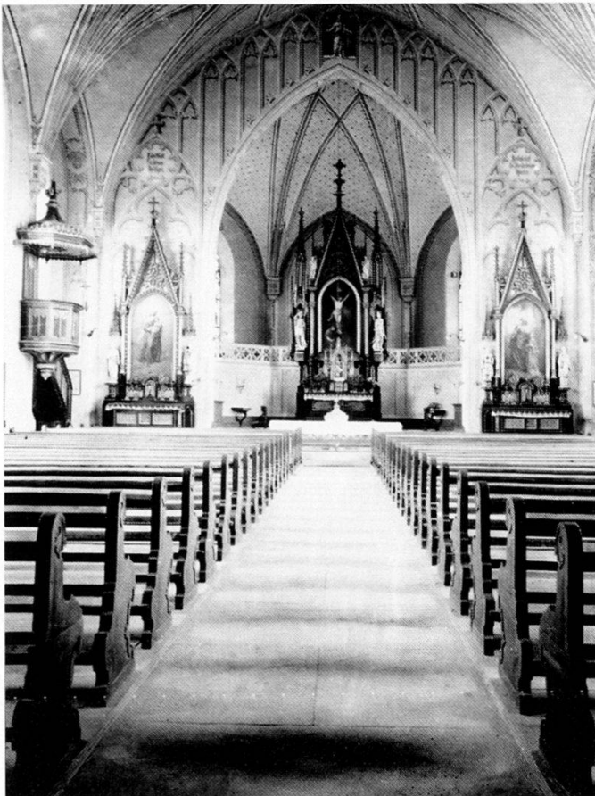
Bünzen, Pfarrkirche. Erste Fassung Dekorationsmalerei.
