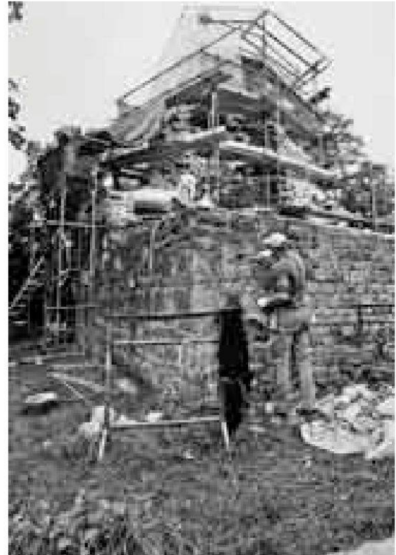
Burgruine Tegerfelden (Gemeinde Tegerfelden). Der eingerüstete Hauptturm während der Sanierungsarbeiten. (Foto: Kantonsarchäologie Aargau)
