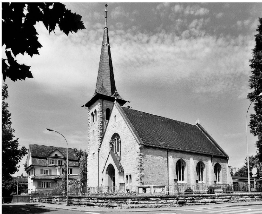
Reformierte Kirche in Bremgarten, Architekt: Julius Kelterborn, erbaut 1899/1900, Aussenansicht (Foto: Kantonale Denkmalpflege Aargau).
