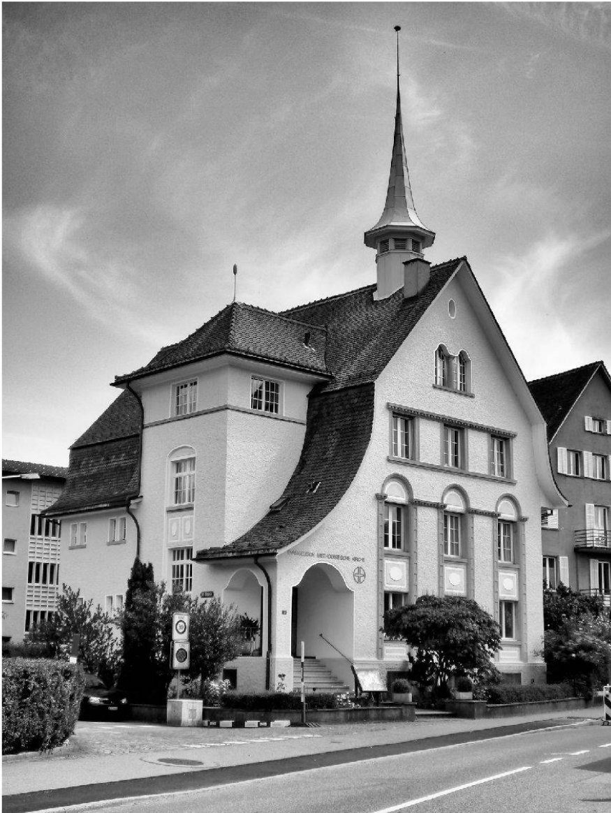
Methodistische Kirche in Baden, Architekten: Gebrüder Braendli, erbaut 1912/13, Aussenansicht (Foto: Kantonale Denkmalpflege Aargau, Aufnahme von Anke Köth).
