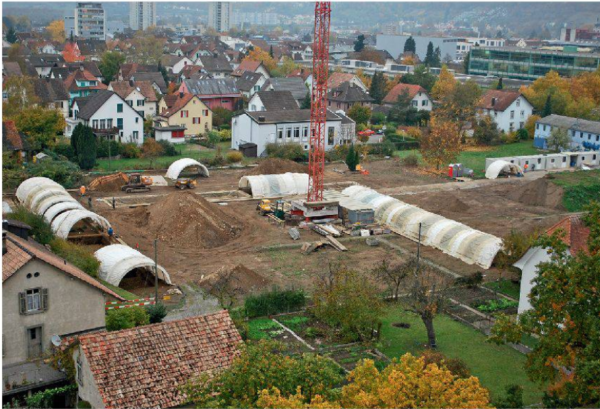
Abb. 2: Windisch. Blick von Südosten auf die Grossgrabung im sogenannten Forum.
