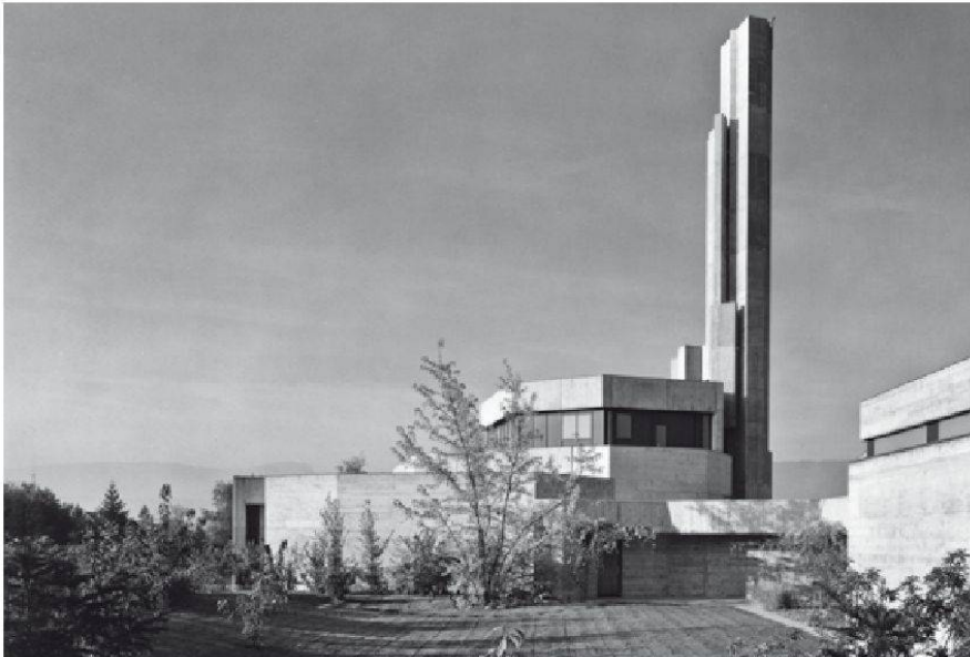
Römisch-katholische Pfarrkirche St. Johannes Evangelist in Buchs, Architekt: Hanns A. Brütsch, erbaut 1965–1967, Aussenansicht (Foto: Postkarte der Kirchengemeinde St. Johannes Evangelist in Buchs, Aufnahme von Foto Erne, Aarau).
