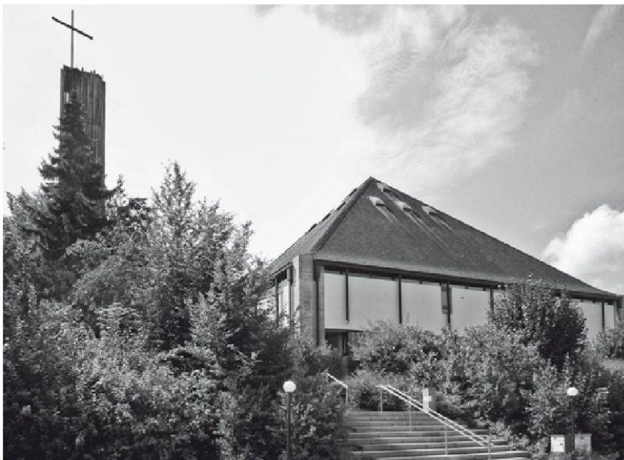
Römisch-katholische Marienkirche in Magden, Architekt: Leo Cron, erbaut 1967–69, Aussenansicht (Foto: Kantonale Denkmalpflege Aargau, Aufnahme von Anke Köth).
