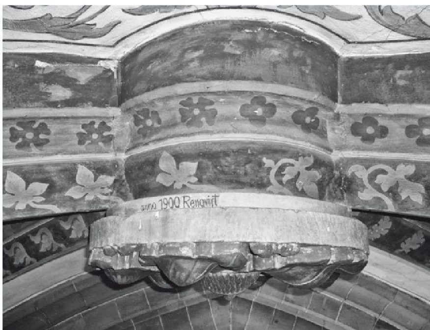
14 Zurzach, Verenamünster, Fotografie eines Schlusssteins im Chor, 2010. Der Dekorationsmaler Christian Schmidt vermerkte an einer vom Chor aus nicht sichtbaren Stelle die Jahrzahl der Restaurierung. (Bild: Isabel Haupt, Kantonale Denkmalpflege Aargau).
