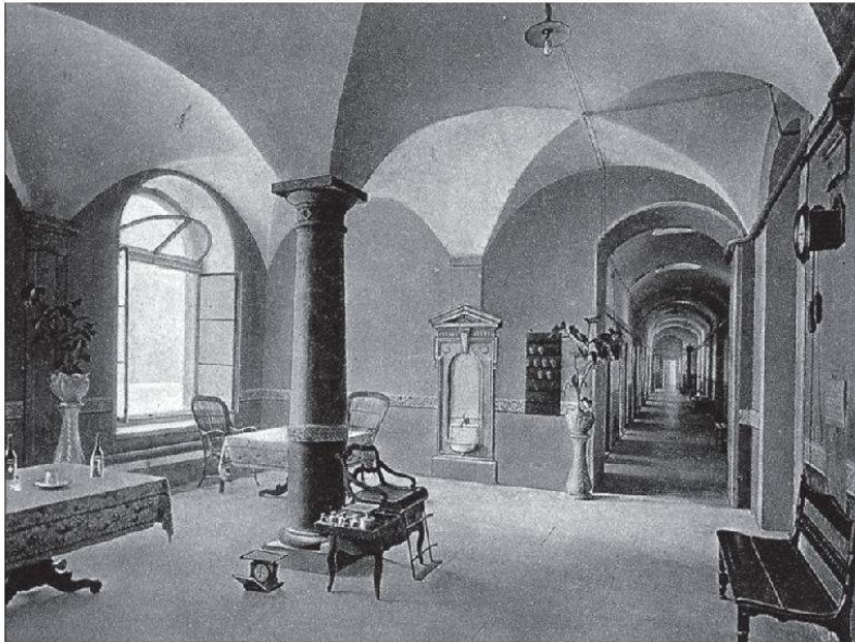
11 Die Bäderwarte Halle im 2. Untergeschoss (Bild: Sammlung Sepp Schmid, Baden).
