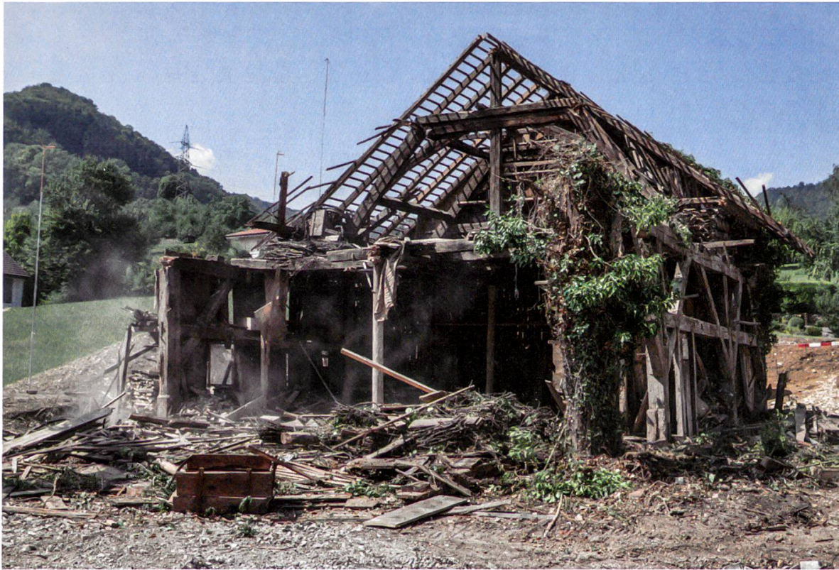
13 Wittnau-Oberer Kirchweg, Anlässlich des Abbruchs der Trotte von 1720 freigelegte Ständerkonstruktion.
