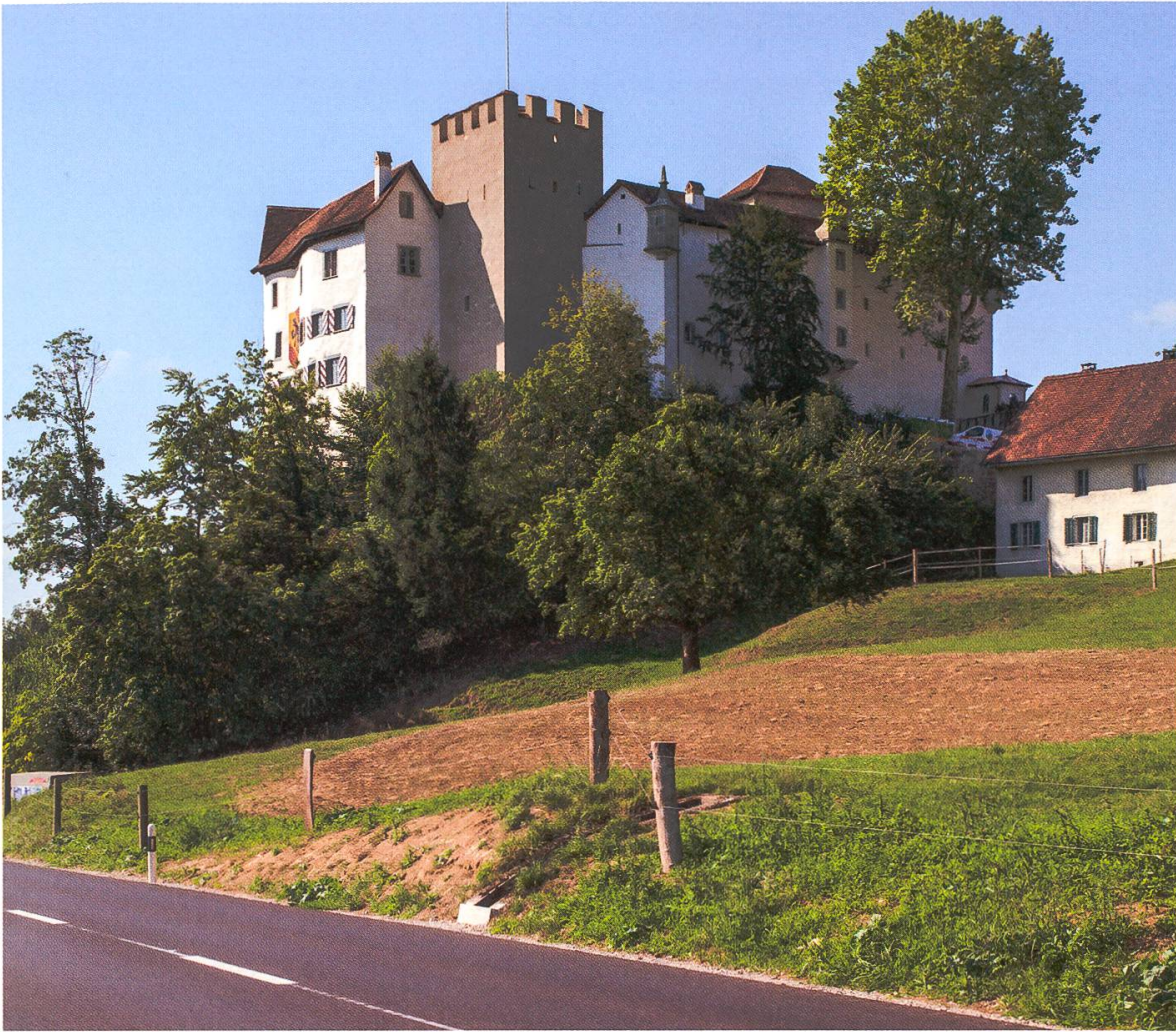
12 Aussenanblick von Wildenstein nach der erfolgten Renovation.
