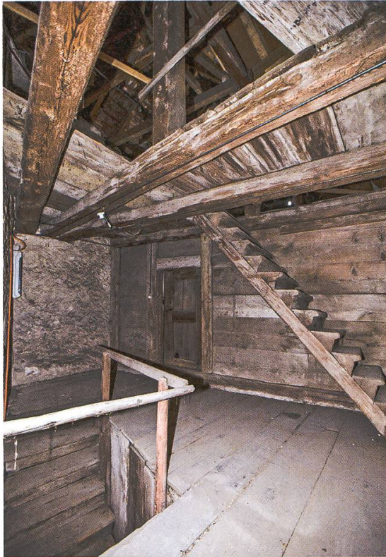
8 Schloss Wildenstein, Nordtrakt, Raum 39: Bohlenwand und Blocktreppe.
